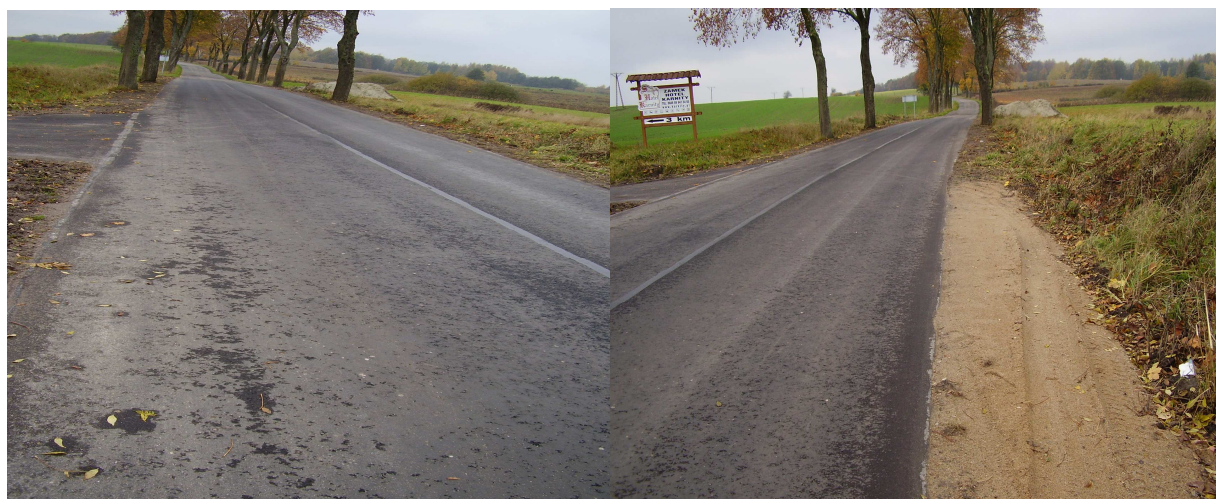
Stan po wykonaniu nakładki
