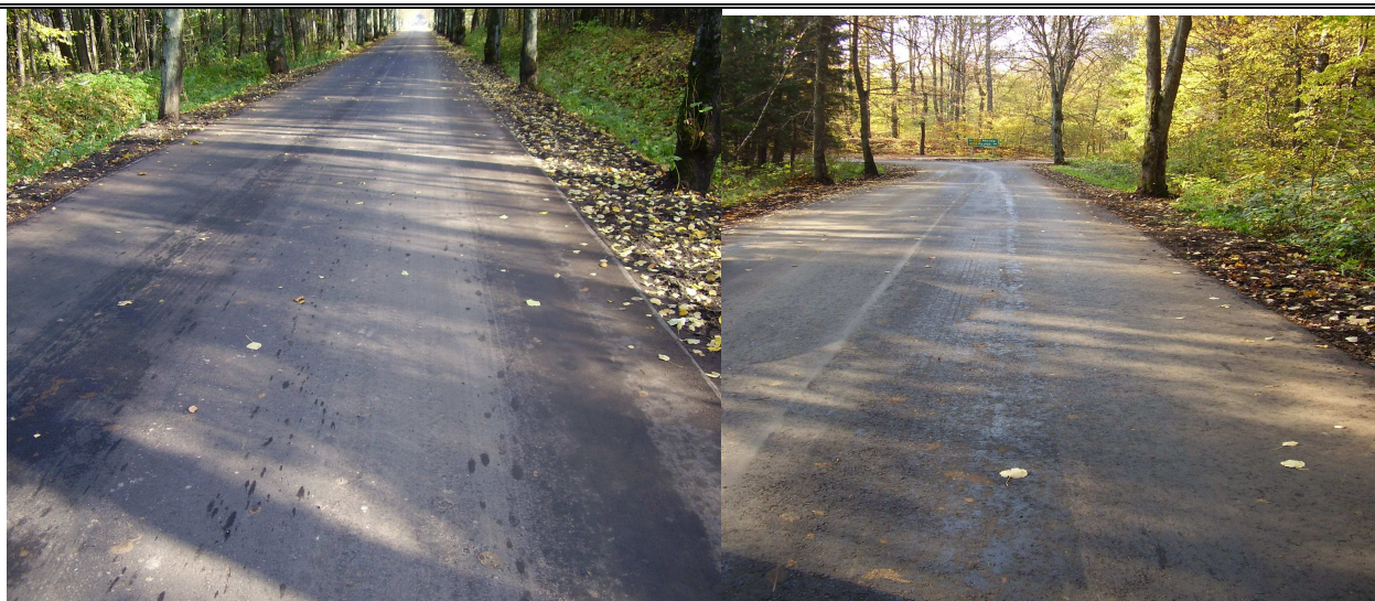
Stan po wykonaniu nakładki
