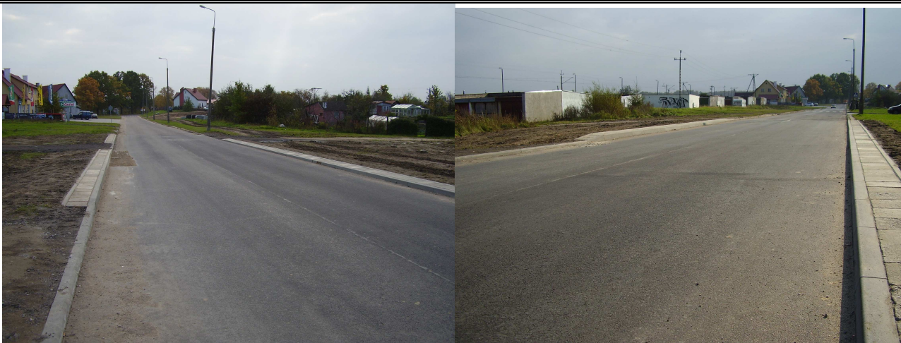
Stan po likwidacji zaniżeń
