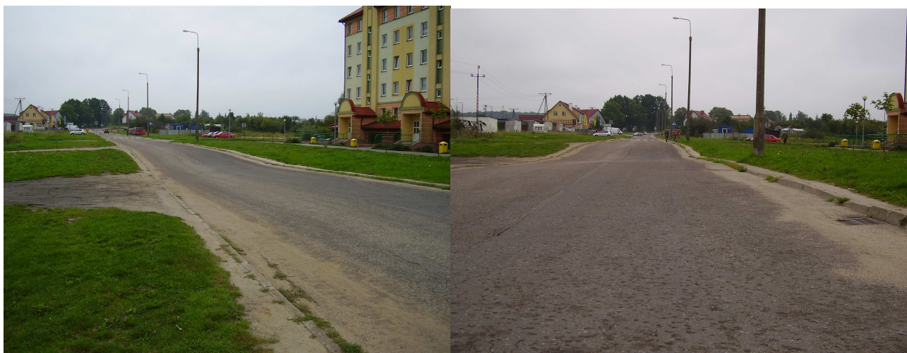
Stan przed likwidacją zaniżeń
