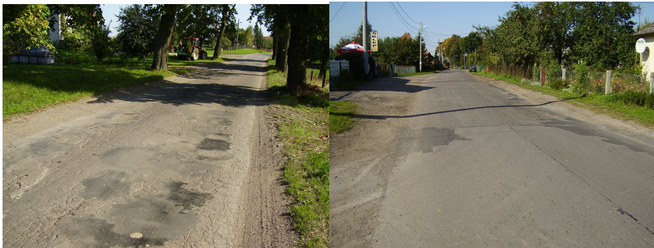
Przed wykonaniem nakładki
