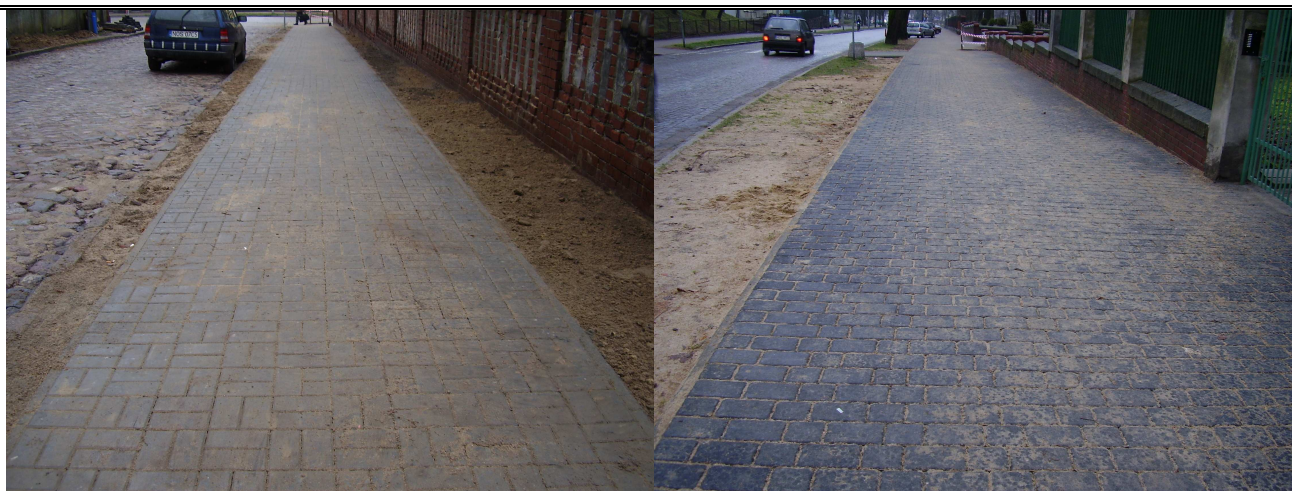
W trakcie robót
