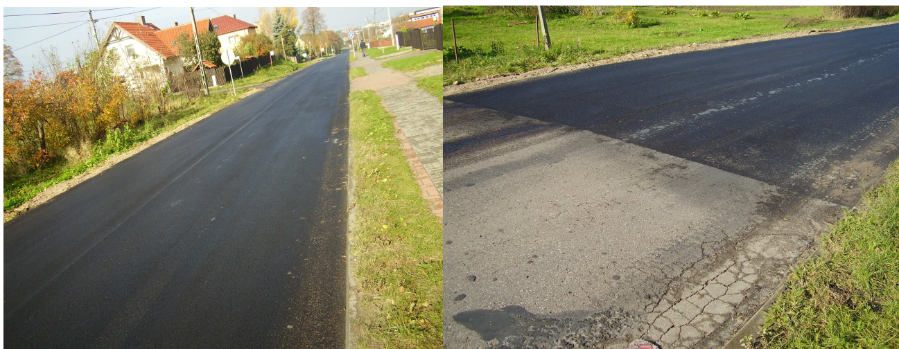
Stan po wykonaniu robót
