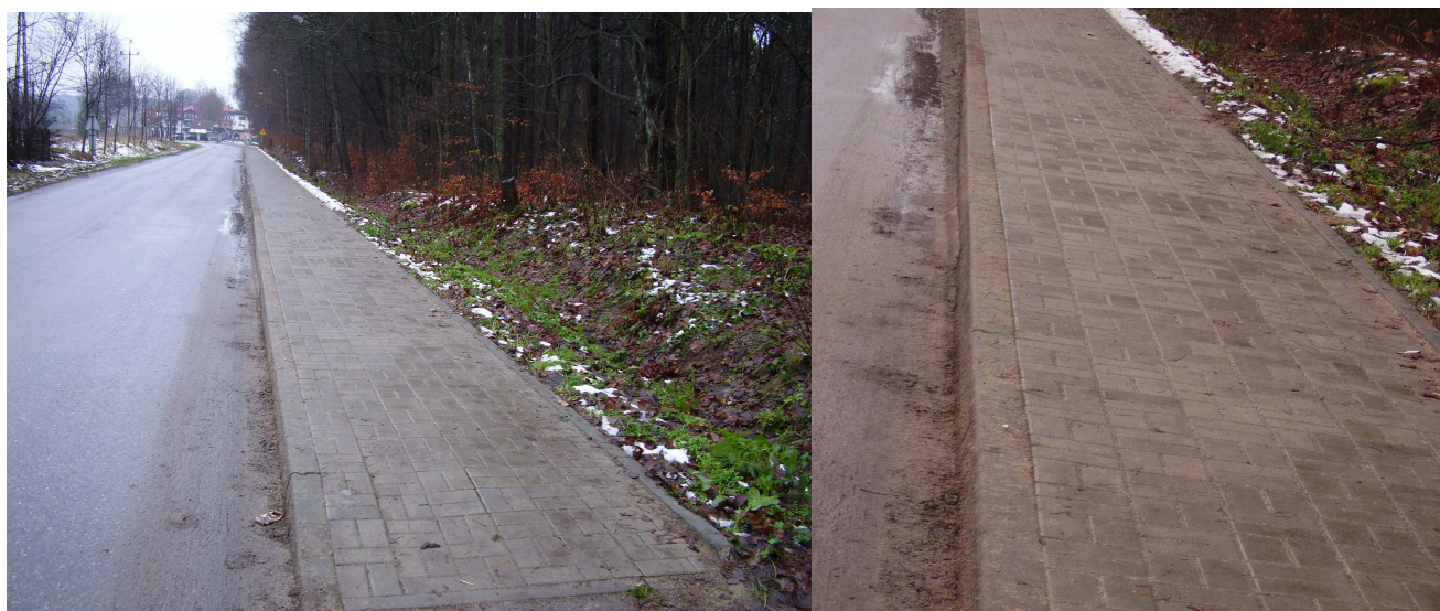
Stan po wykonaniu chodnika
