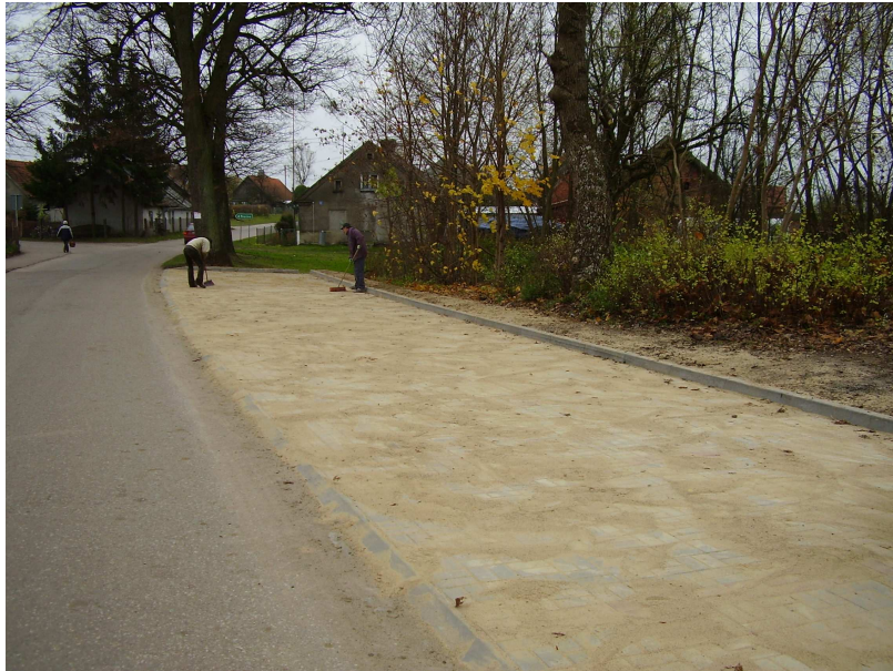
Stan po wykonaniu zatoki
