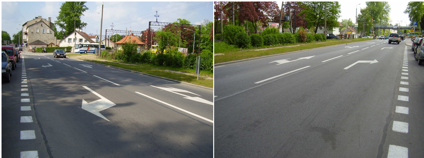
Stan po wzmocnieniu nawierzchni
