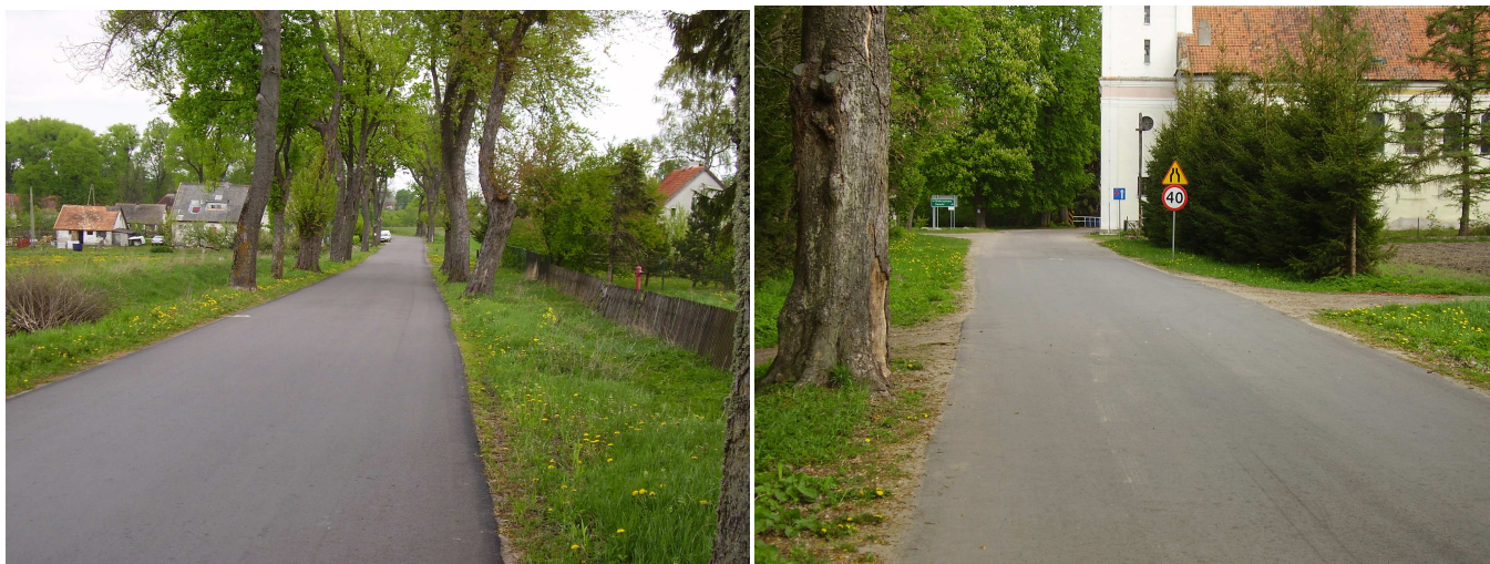
Stan po wykonaniu nakładki
