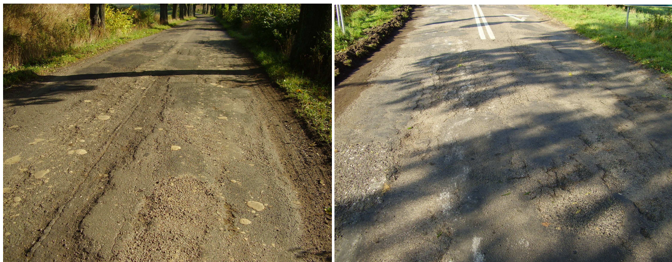
Stan przed wykonaniem nakładki
