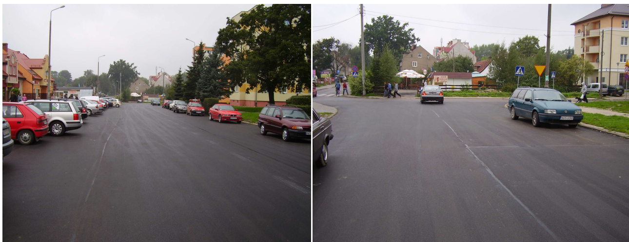
Stan po wykonaniu nakładki
