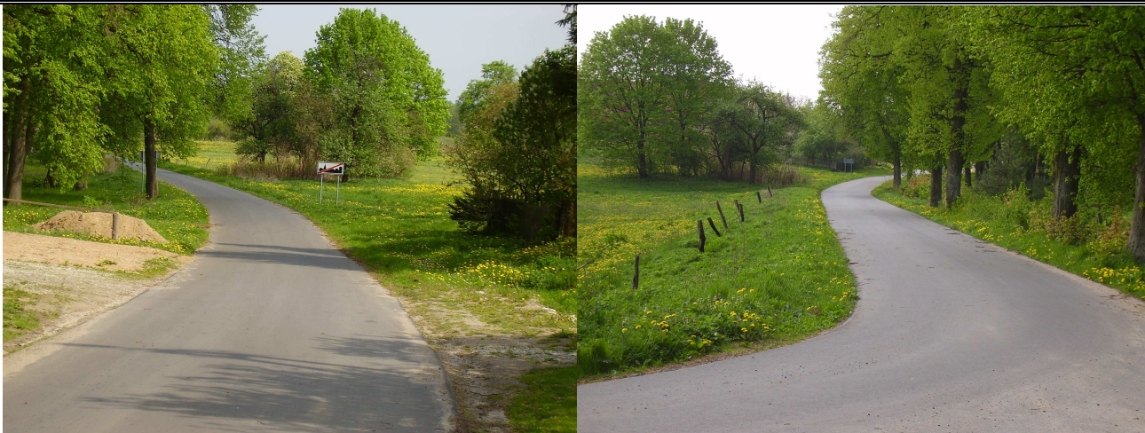
Stan po wykonaniu nakładki
