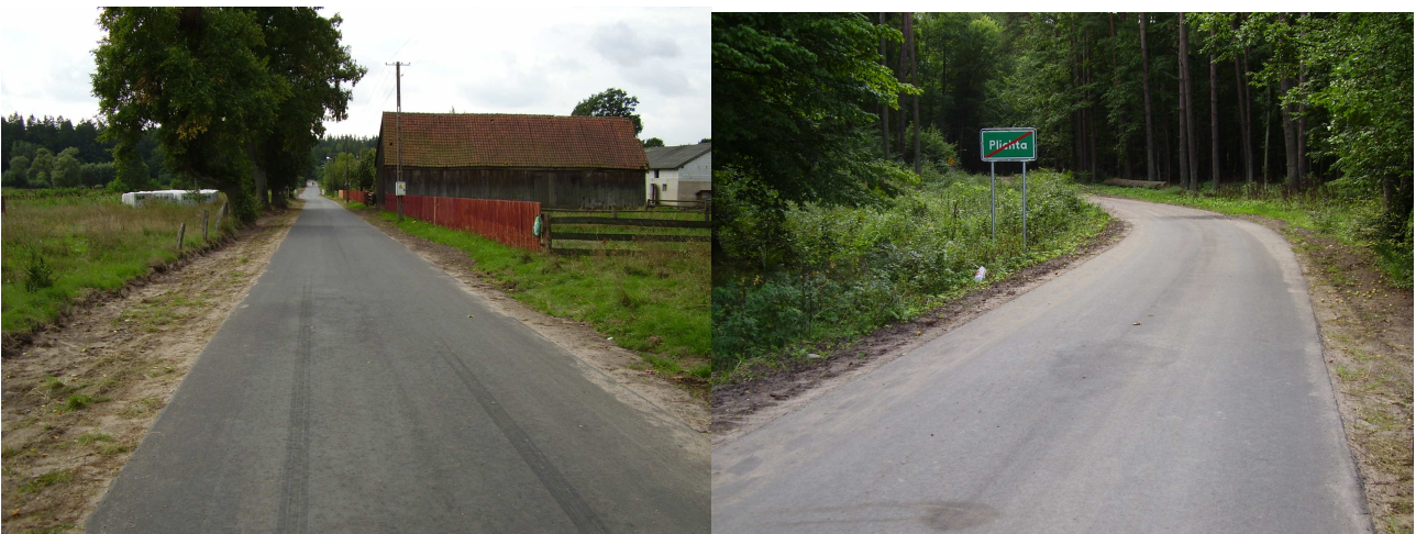
Stan po wykonaniu nakładki
