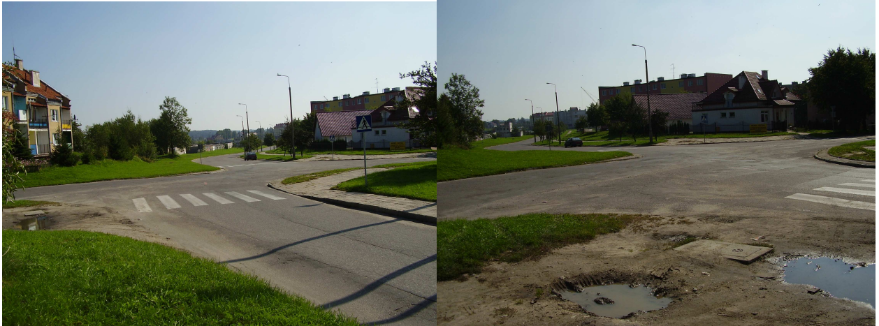
Stan przed przebudową
