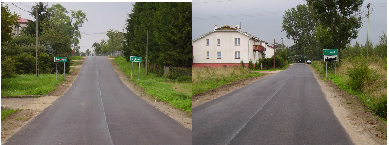
Stan po wykonaniu nakładki
