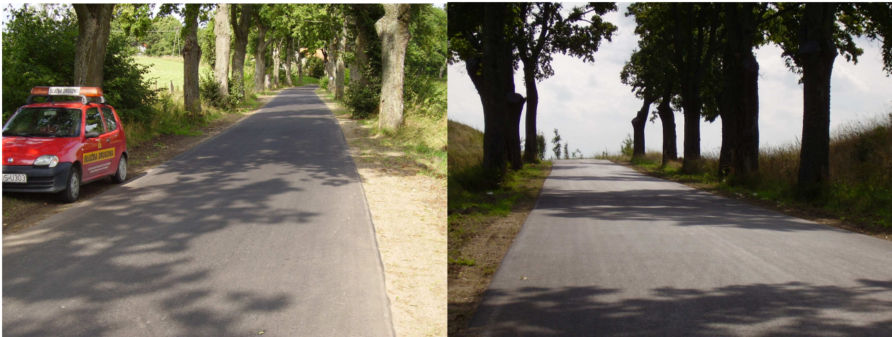
Stan po wykonaniu nakładki
