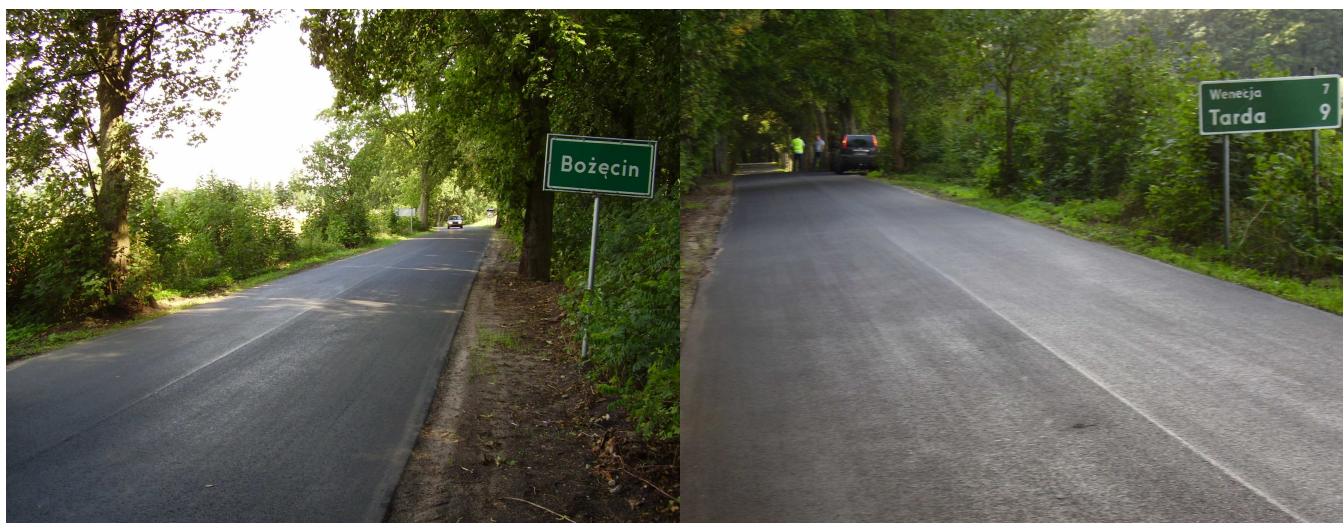
Stan po wykonaniu nakładki
