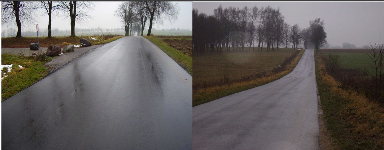
Stan po wykonaniu nakładki
