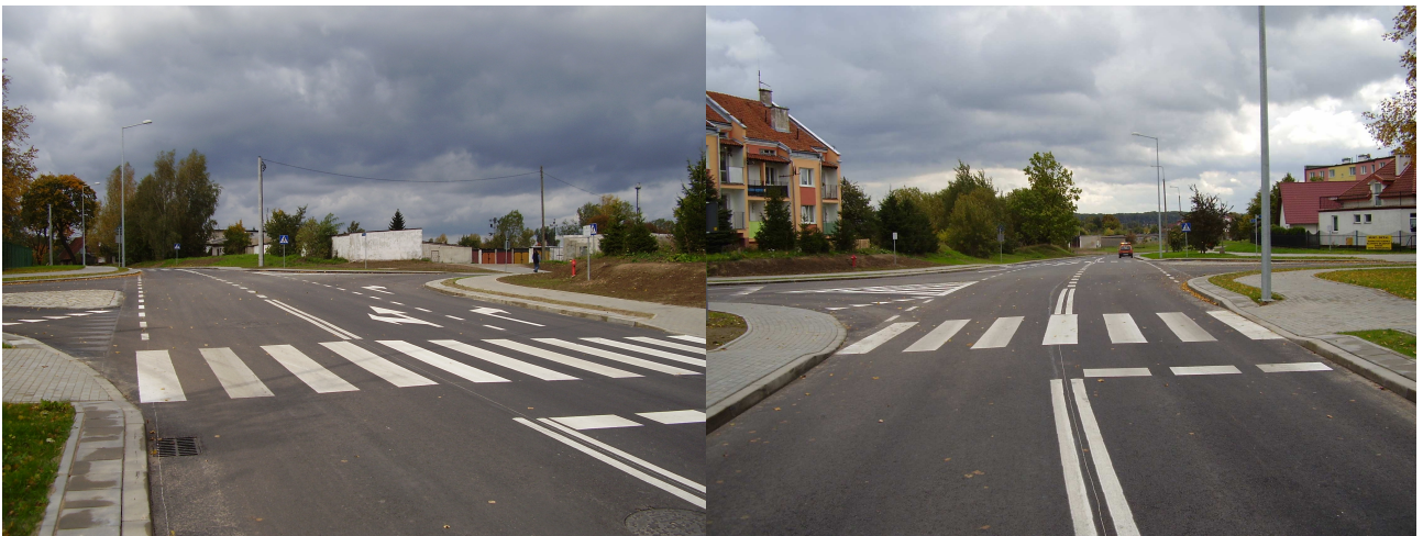
Stan po przebudowie
